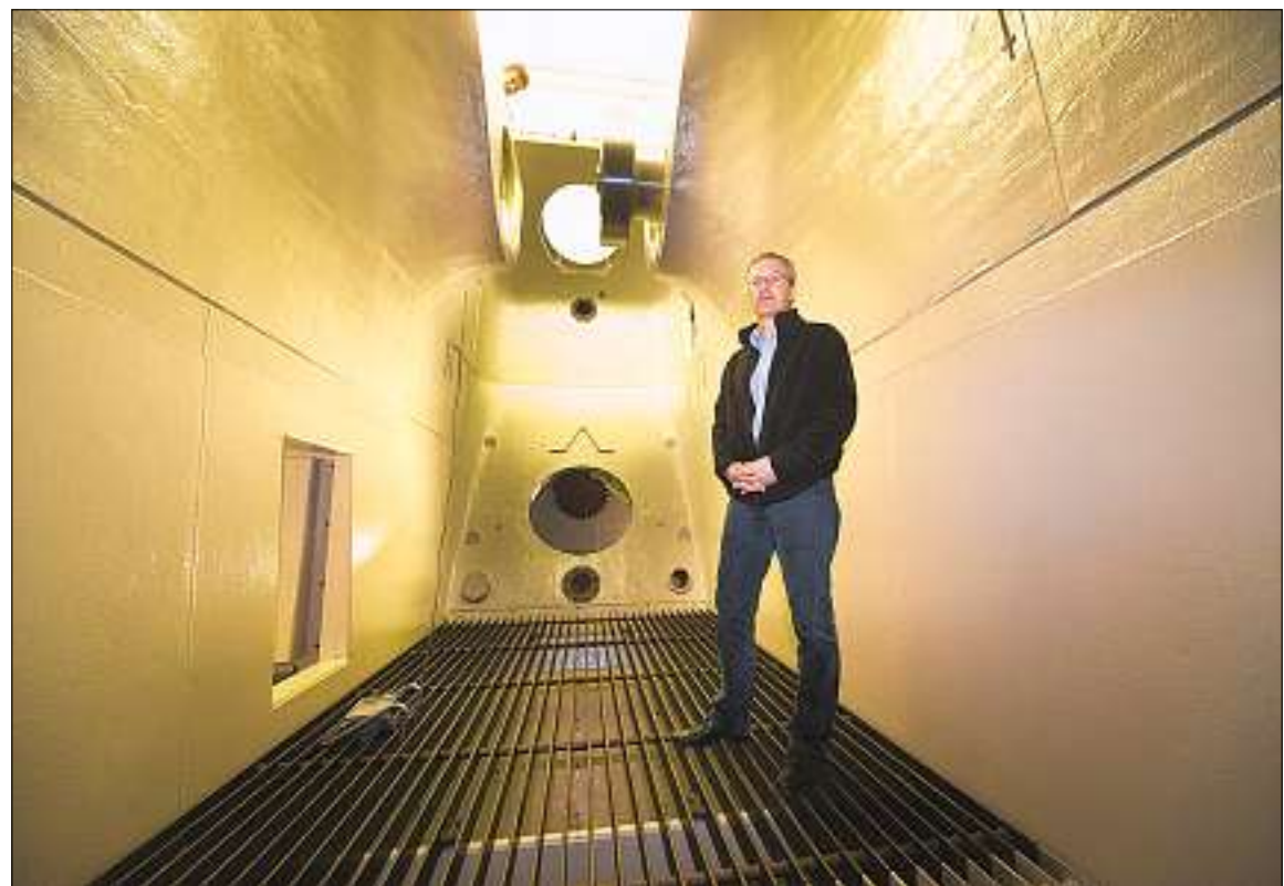
Jörg Huwyler zeigt den Raum, in dem bald eine riesige Turbine stehen wird. (Foto Marco Hartmann)
