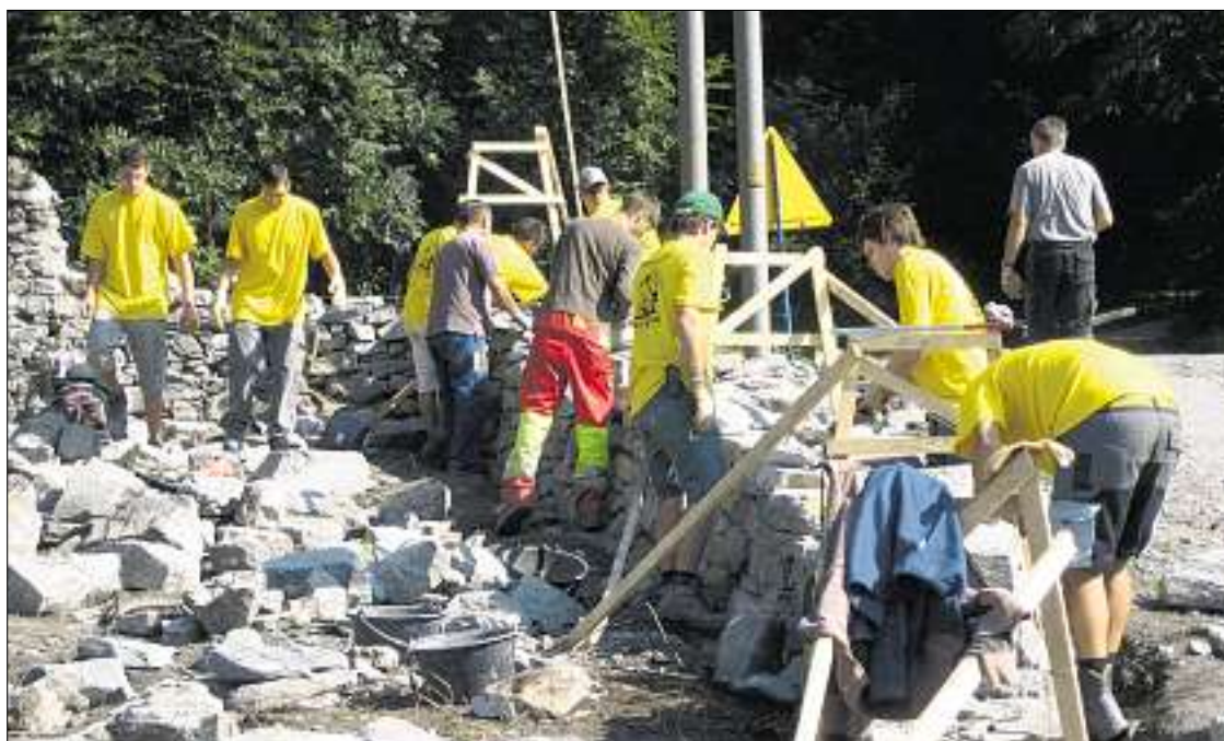
Eine Gruppe beim Aufmauern.
