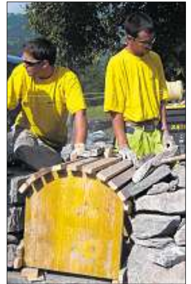
Fachmännisch wird beim Bau eines Rundbogens vorgegangen.
