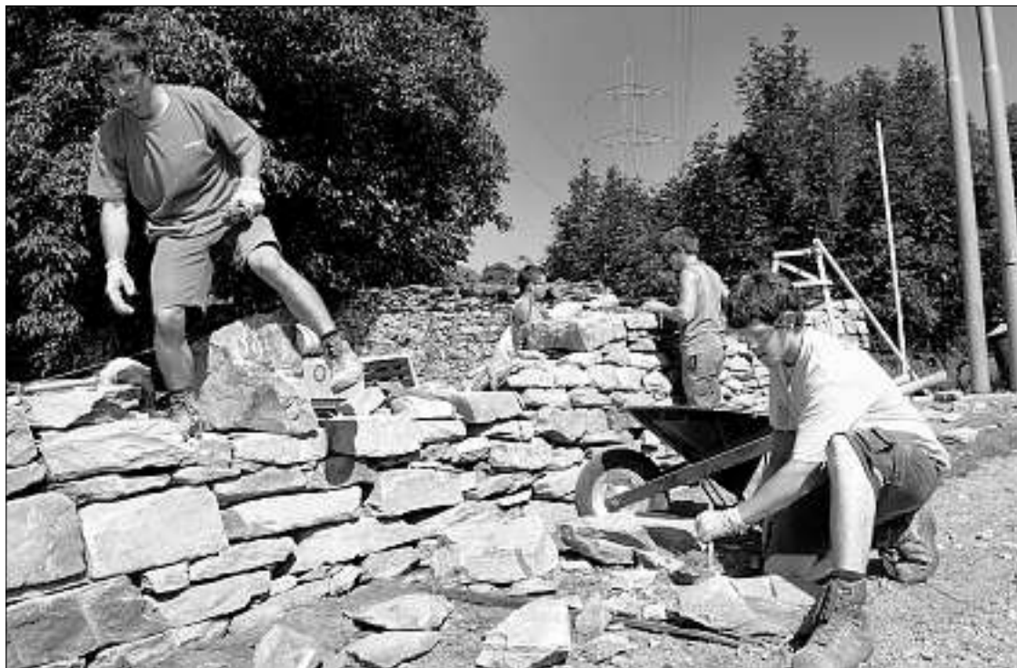
Stein um Stein: Zürcher und Bündner Lernende lassen im Gebiet Crestabongert in Fürstenu das historische Handwerk des Trockensteinmauerbaus neu aufleben. (Fotos Jo Diener)
